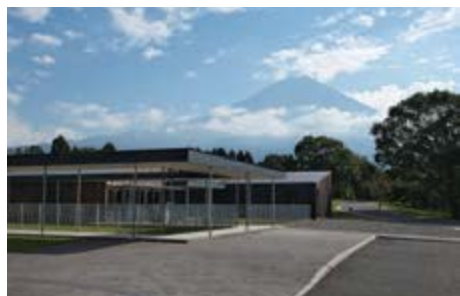
④ 4 訓練センターの中で最大の敷地面積、床面積を誇ります
