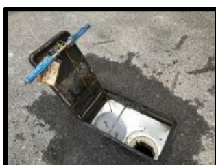
②蓋を開けハンドルを取り付けると和式トイレとして使用可。 ※洋式で使用する場合は折り畳み便座を設置。
