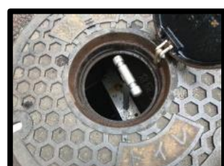
④貯留弁を引いて下水管へと流す。 ※貯留弁は重いため引くときは注意。
