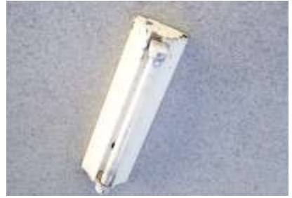
蛍光灯の塗装剥がれ
