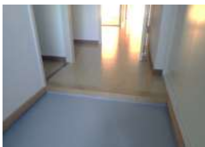
上がりかまち段差
