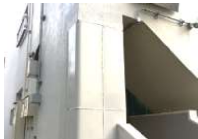
1階柱の耐震改修(実施済み)
