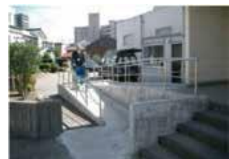
①スロープの設置
