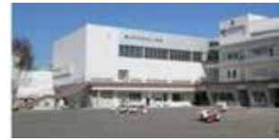
①② 2階の屋内運動場と屋外階段 （江戸川区提供）
