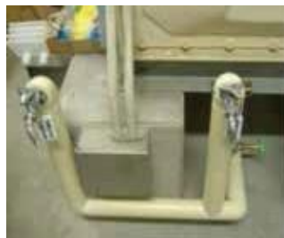
④受水槽への蛇口の設置
