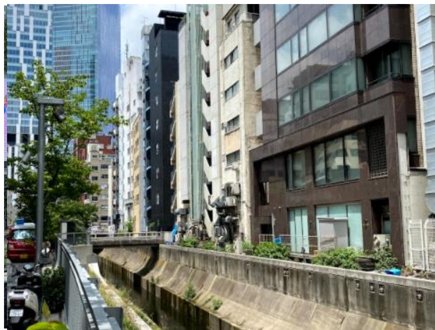
渋谷川・明治通りに挟まれた建物
