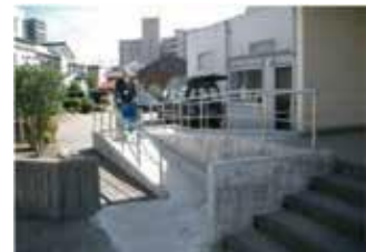
①スロープの設置
