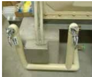
④受水槽への蛇口の設置
