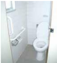
②屋内運動場トイレの洋式化
