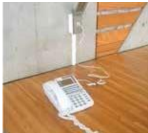
③屋内運動場への電話配線の設置
