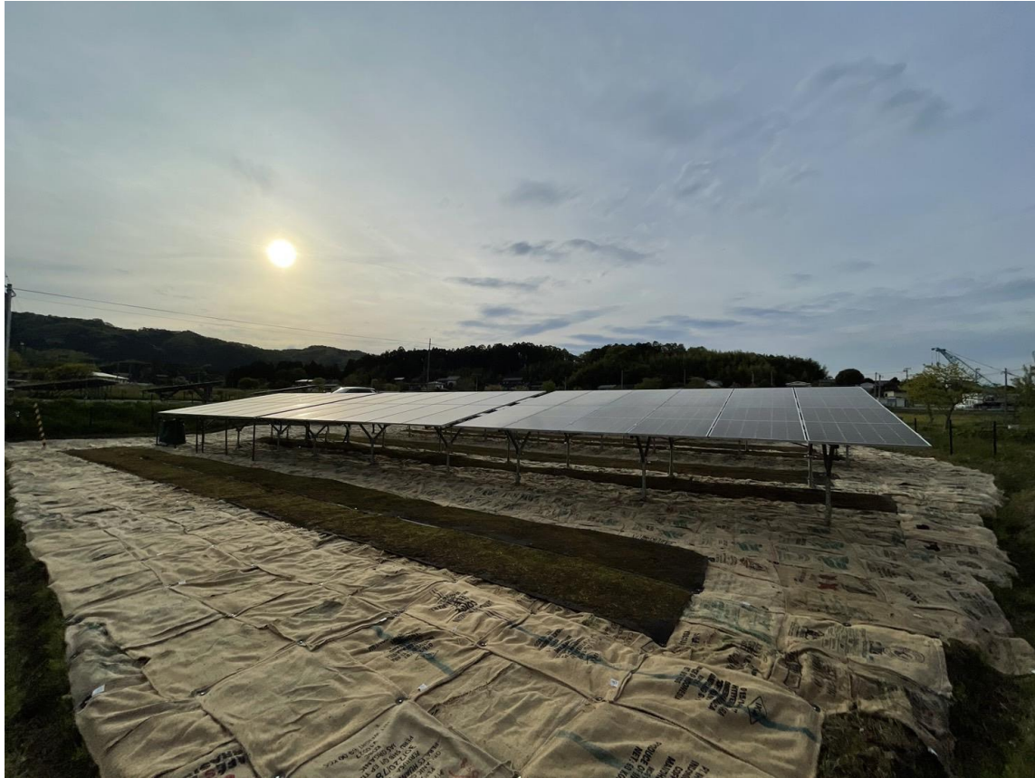
施工直後 (現在の実際の写真)
