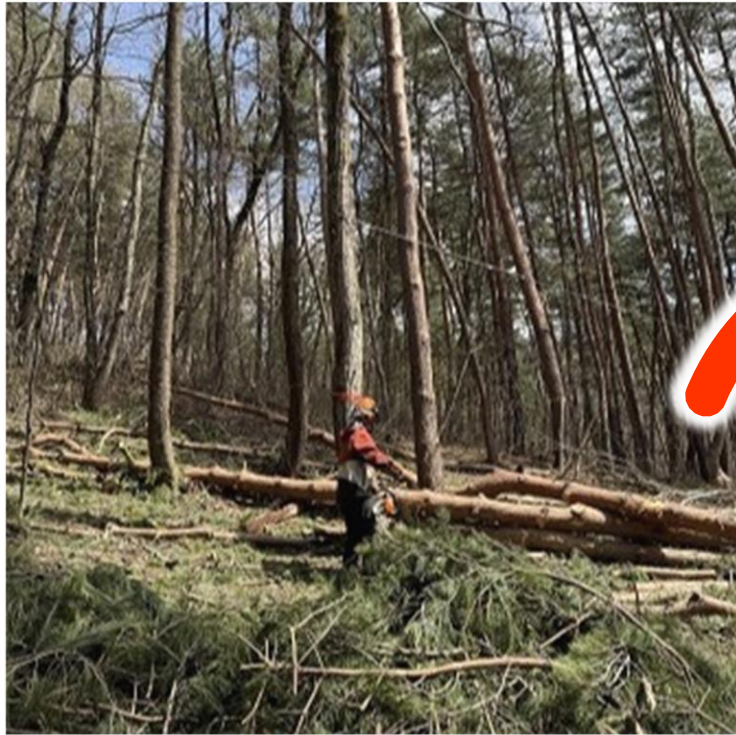
電力会社による電線の下 の木の保安伐採
