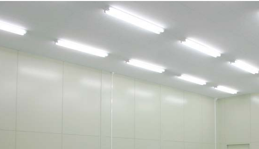
化粧石膏ボード天井
