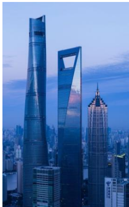
上海環球金融中心 2008年8月竣工
