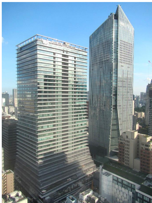
虎ノ門ヒルズ ビジネスタワー 工事現況(2019年9月撮影)
