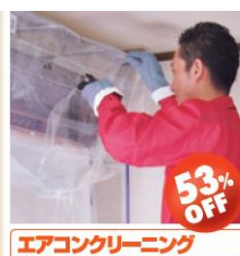
エアコンクリーニング
