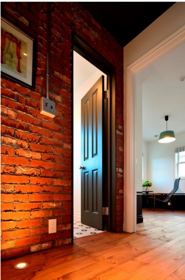
【写真④2階ホール】 荒仕上げのタイルに露出配管した照明スイッチ
