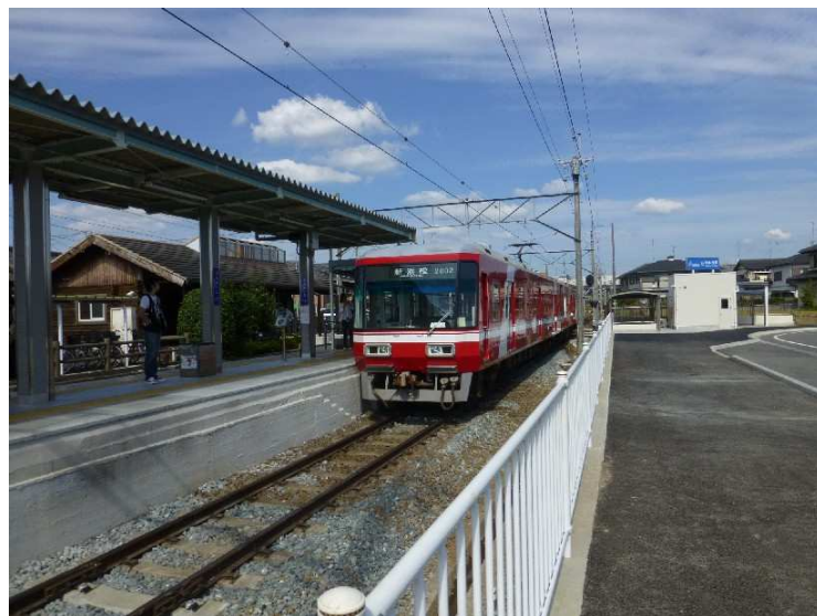
↑東西両方面からの乗降が可能となった遠州岩水駅
