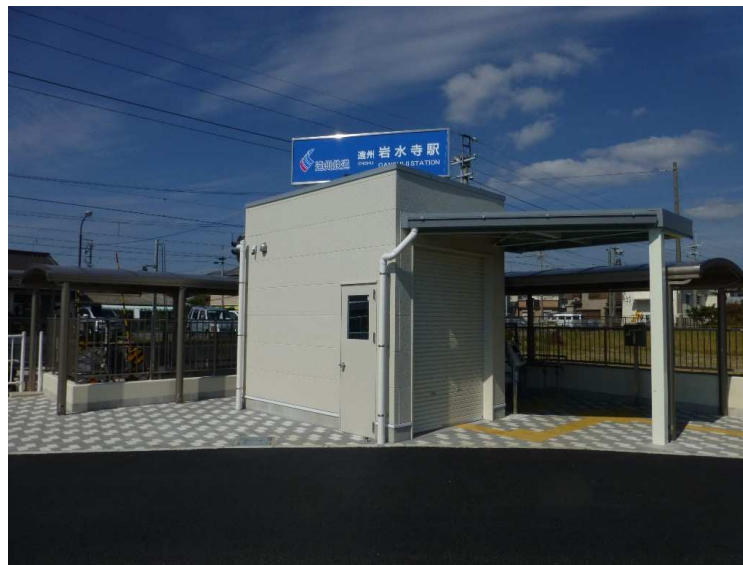
↑線路東側に新設した入場口
