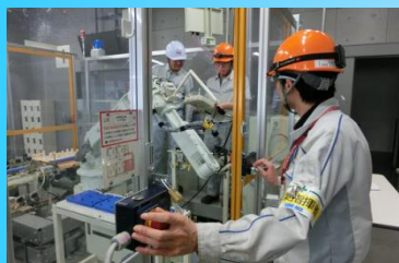
工場設備の保全作業
