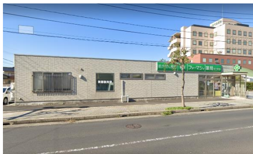
調査対象施設の外観
