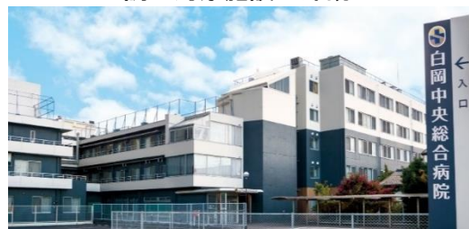
調査対象施設の外観
