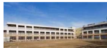
学校を改修して整備した住宅
