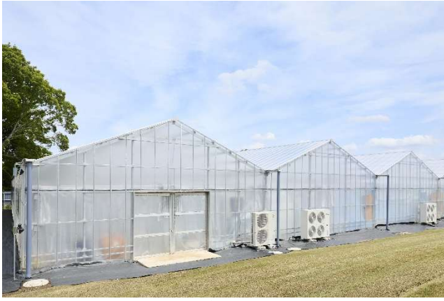
太陽光利用型植物工場外観
