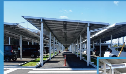
歩道(通路シェルター)への設置例
