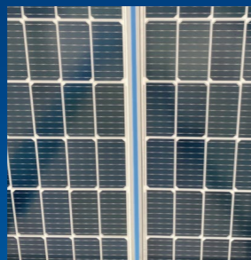
止水なし: パネル敷設時
