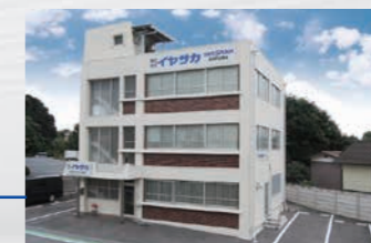
●関東支店・埼玉営業所
