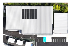
「太陽光発電システム」
