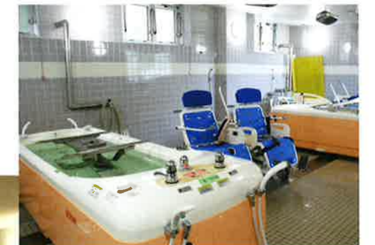
入浴棟(特別浴室)
