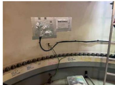
ひずみゲージを設置
