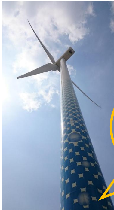
横浜市風力発電所（ハマウイング）
