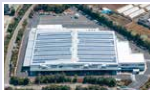
太陽光パネル2000枚を敷き詰めた工場屋根
