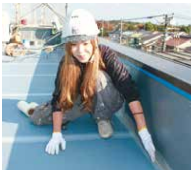
屋上防水工事の様子
