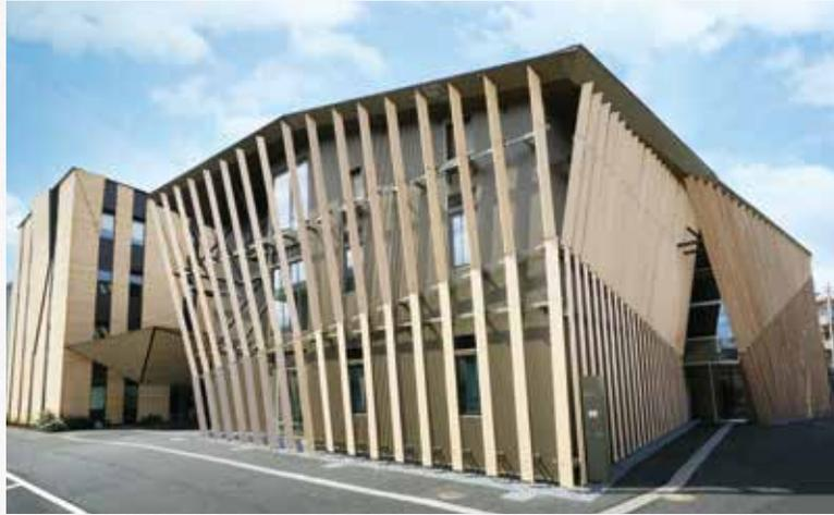
既存の校舎同様、隈研吾氏デザインの木造の校舎。ホール部分はCLTを構造体だけでなく、仕上げ材としても使っています。建物内の天井や壁はCLTそのものです。外観に見られるルーバーは、ピアノやバイオリンなど楽器の弦をイメージしています。ルーバーには、角度に違いをつけており、外から見ると角度によって建物全体の表情が変化します。
